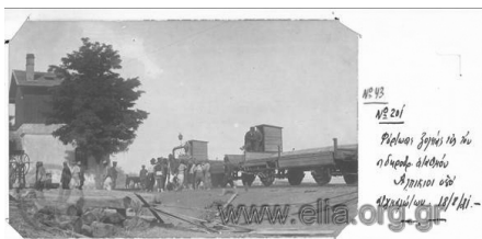
Φωτ. 12. Σιδηροδρομικός Σταθμός (Τοποθεσία Αλπικοί).
